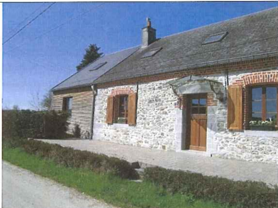
Extension d'une maison élémentaire à Eppe-Sauvage
