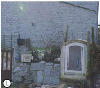
L Niche dans mur de clôture , 726 rue de Beaumont
