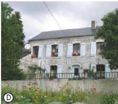
Ancien Presbytère, rue de l'Eglise
